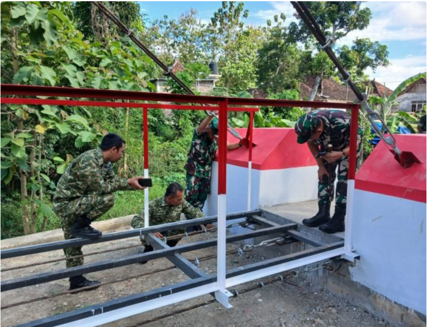
Babinsa Koramil 19/Trucuk Dampingi Dandenzibang Surakarta Tinjau Progres Jembatan Gantung Garuda
