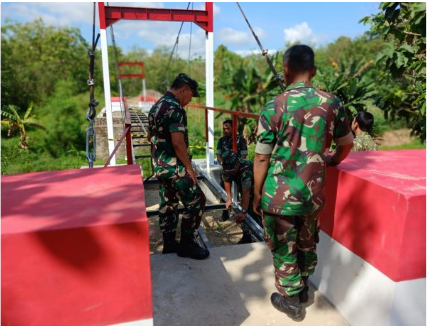
Dandenzibang Surakarta Tinjau Progres Pembangunan Jembatan Gantung Garuda Di Karangpapel
